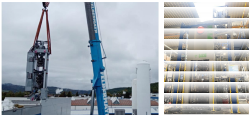
Výkladka 300t lisu SACMI (vľavo), lis po úspešnej inštalácii (vpravo)
