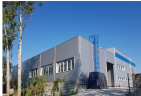
Prístavba k výrobnéj hale – kolaudácia 11/2022
